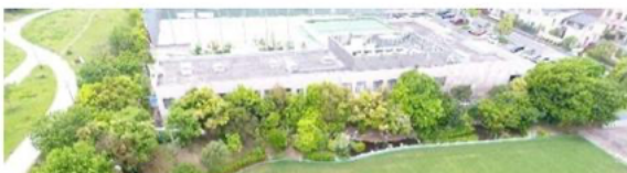
写真 1 小学校の概観（中央の緑帯はビオトープ）
