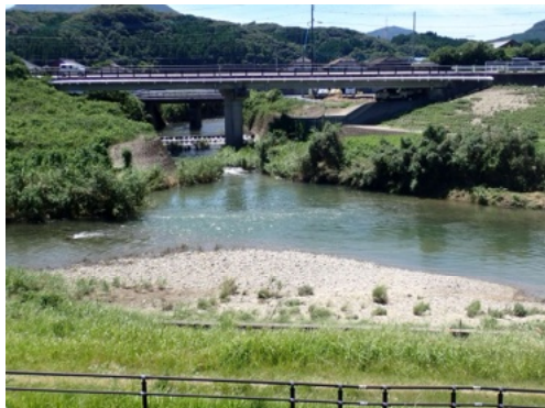
図5 厳木川と平山川の合流部(唐津市)
