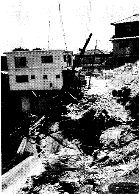
写真1 盛土・切土境界に建てられた住宅の倒壊 〈西宮市五月ヶ丘〉
