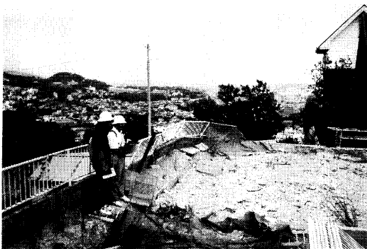
写真2 盛土・切土境界に建てられた住宅の倒壊 〈西宮市五月ヶ丘〉
