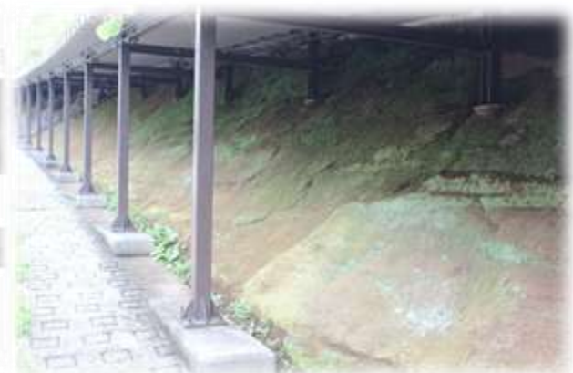
伊良尾(イラオ)山
