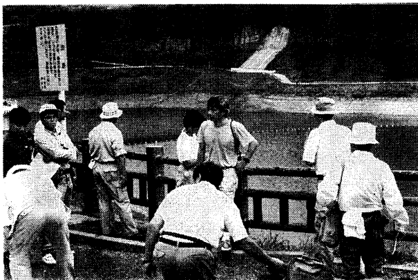
第3コース：荒川ロックヒルダム
